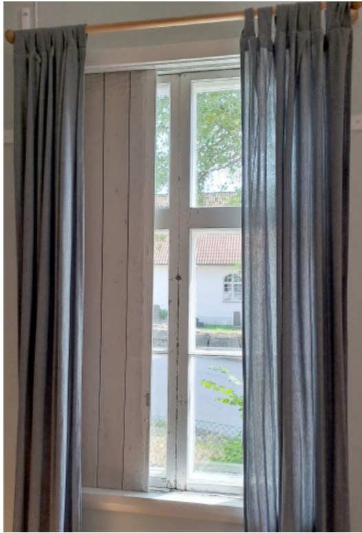
Fönster med invändig fönsterlucka.
