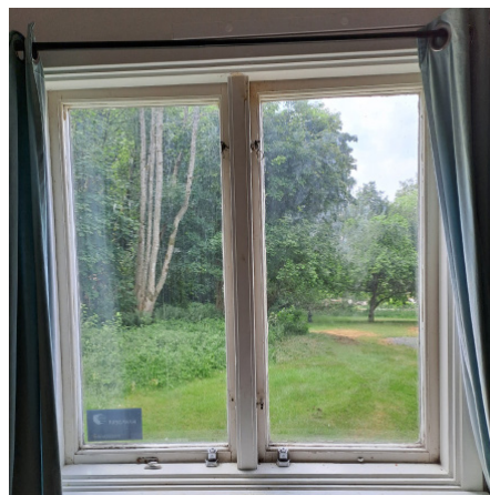
Fönstren är utåt gående med två lufter i fast mittpost
