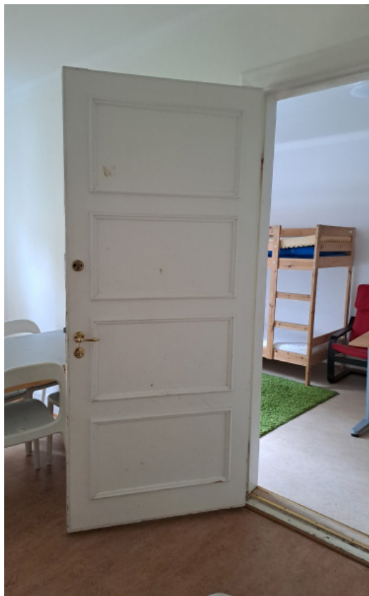
Dörrarna har blivit isolerade och fått påspikade lister.
