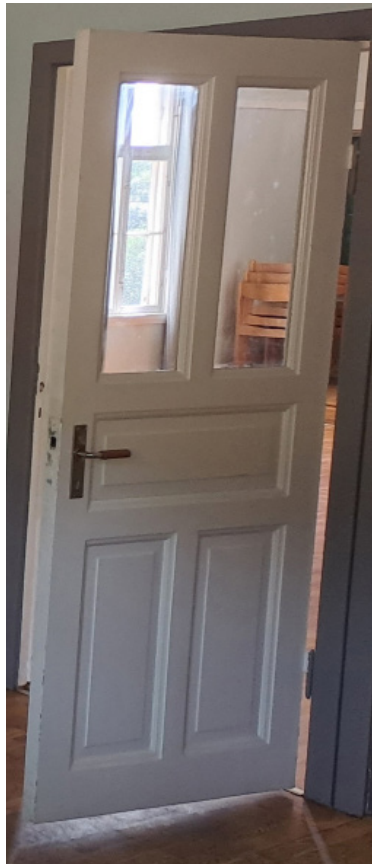
Äldre dörrar i byggnaden. Notera "skurklossen" som binder samman dörrfodret med golvlis-ten.
