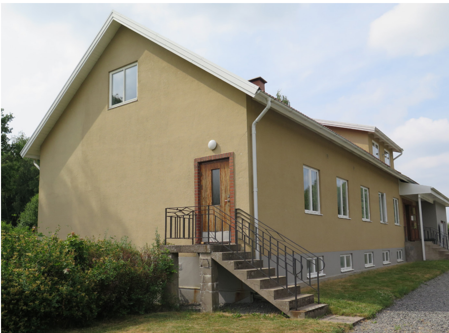
Byggnaden är till sitt yttre välbevarad dock har fasaden vid något tillfälle putsats om och fått ett något stelt uttryck.
