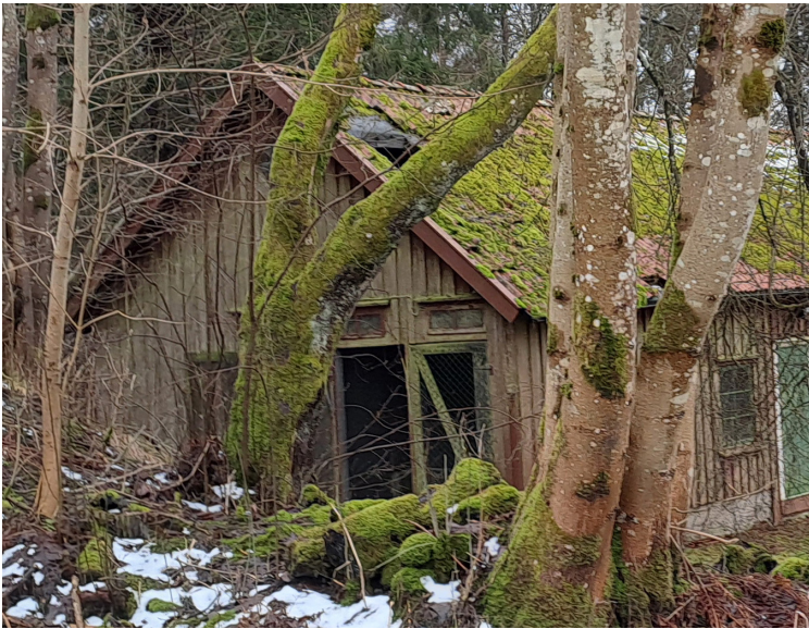
Uthusets östra fasa.
