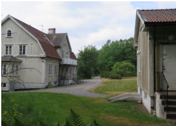
Entrésidan sedd från söder.
