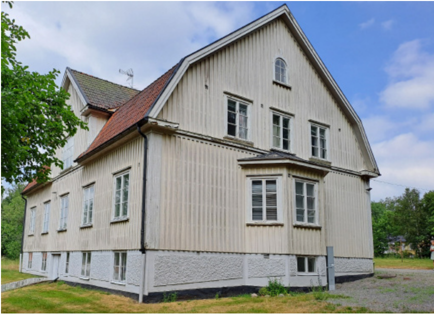
Gavelröset är väl inramat och hörnen markerade. Sockeln är putsad där slätputs ramar in spritputsade fält.
