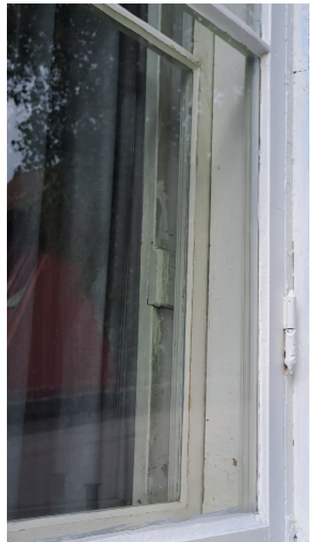
Fönstren i det södra rummet har invändiga fönsterluckor för mörkläggnig. På bilden syns infällningen i väggen. Fotot taget utifrån.
