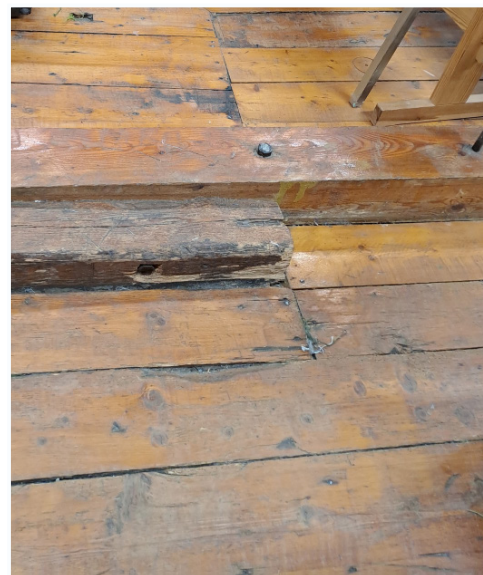
Vinden har delvis ett äldre golv som kan vara från originalhuset/sädesmagasinet.
