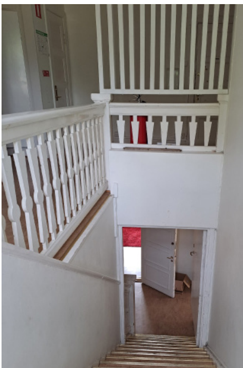
Trappan med räcken.
