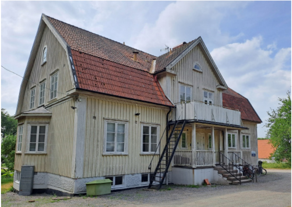
Taket är ett brutet sadeltak med frontespiser. På den östra fasaden är huvudentrén placerad. Den nås via en öppen taktäckt veranda. Över den finns en balkong med en evakuerings steg. Notera de med slät panel markerade hörnen.
