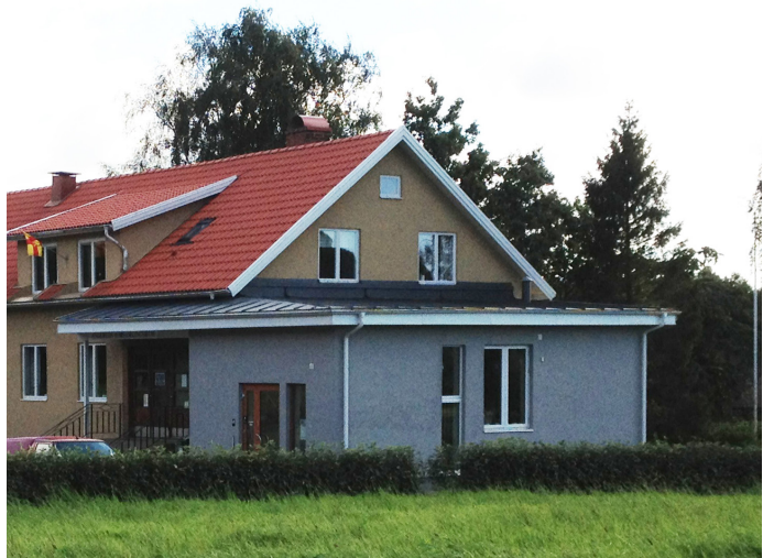
Tillbyggnad tillkom 2012 och innehåller en tillgänglig entré med hvc och hiss till källare och plan 1. Utbyggnadens tak sträcker sig över och skyddar den ursprungliga entrén.
