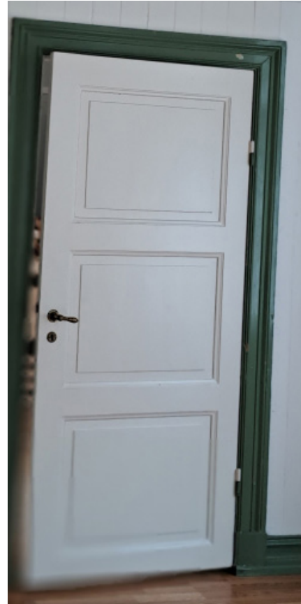
Äldre dörrar i byggnaden. Notera "skurklossen" som binder samman dörrfodret med golvlis-ten.
