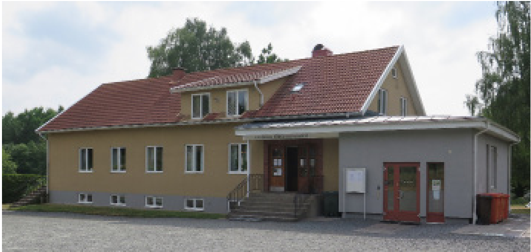
Fasaden är putsad med en enkel utformning och med fönster jämnt fördelade över fasaden.
