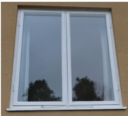
Originalfönstren har två luffer och är utåtgående med fast mittpost.
